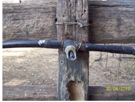
Imagen 43: Bebedero tipo chupete instalado.
