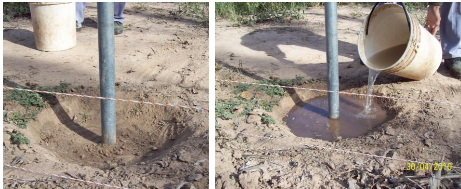
Imágenes 31 y 32: instalación de la toma a tierra.
